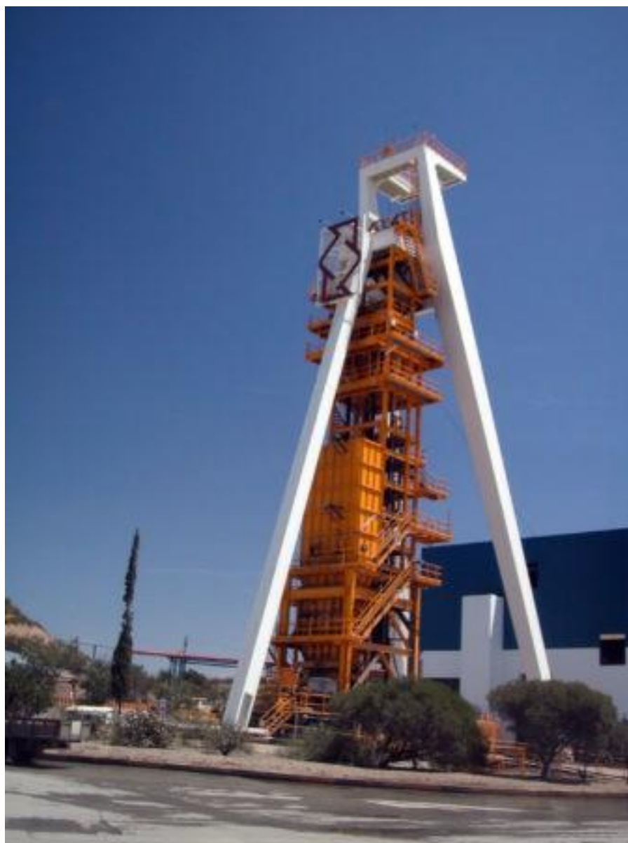
Pozo Santa Bárbara de la mina de Neves Corvo. El acceso se hace por un plano inclinado, sin embargo. Este pozo se utiliza para la extracción del mineral.
