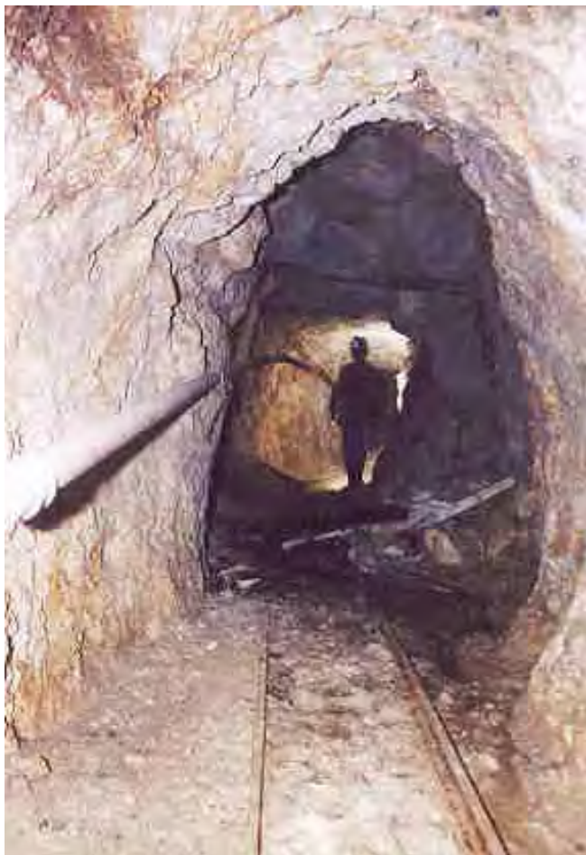
Figura 113: Galería de la mina La Montañesa. Nótense los raíles y la tubería el aire comprimido (2002).
