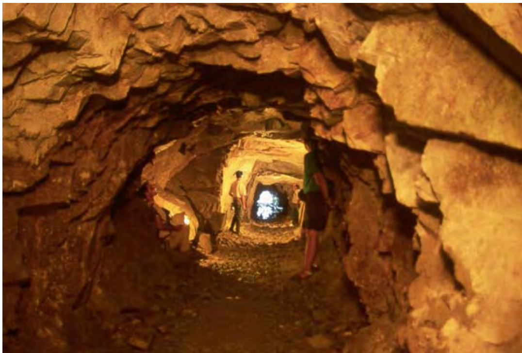
Figura 172: Galería de arrastre (Cortesía Bocamina). Nótese las dos secciones “tipo”: una en forma de herradura en primer plano y otra con techos y hastiales rectos en segundo plano.
