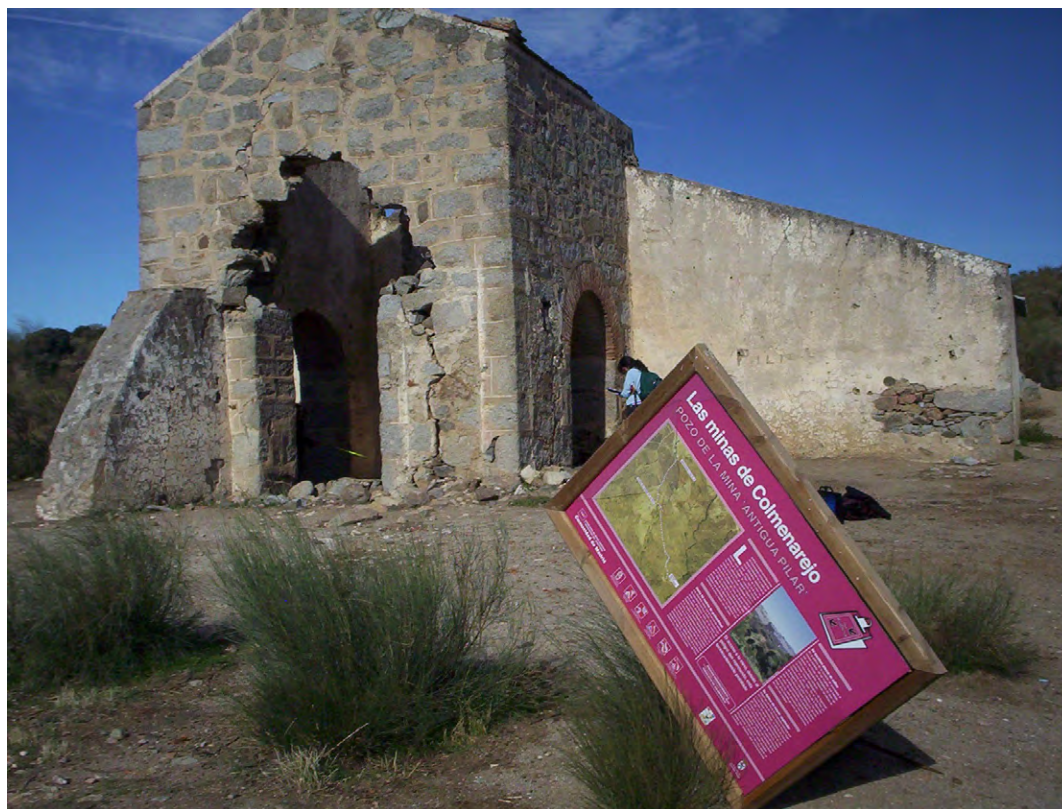
Figura 115: Pozo Maestro de la mina de cobre Antigua Pilar de Colmenarejo. Cartel informativo destruido (2007).
