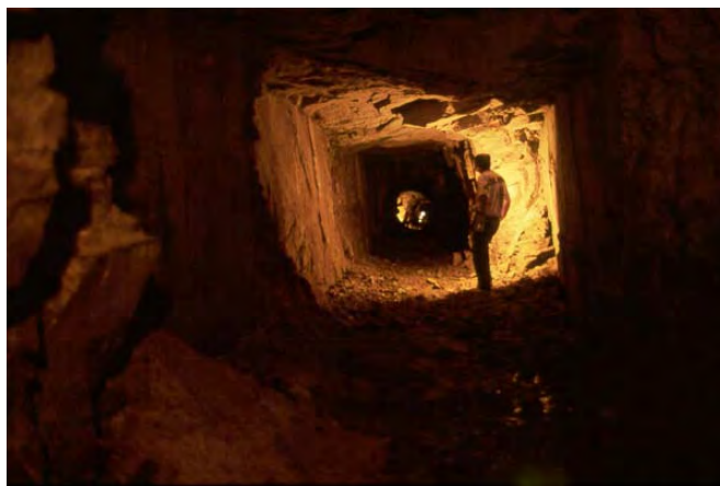
Figura 150: Vista de la galería de arrastre de la mina Primera en Cabeza Lijar, Guadarrama (cortesía Bocamina).
