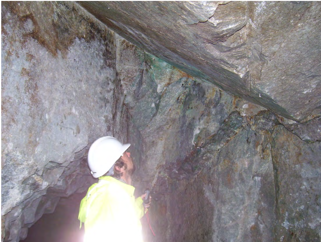
Figura 170: Detalle de una cuña ya caída. Entorno de la estación geomecánica 1 (fotografía tomada en 2007).
