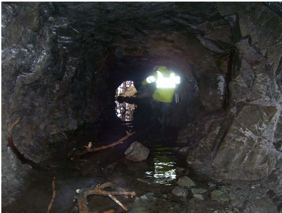
Figura 14: Galería de arrastre en estéril.
