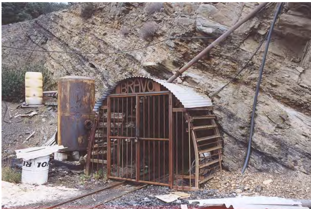
Figura 55: Sostenimiento mediante cerchas TH en un emboquille de mina (Bembibre, León). Nótese el arriostramiento de los cuadros mediante tresillones.
