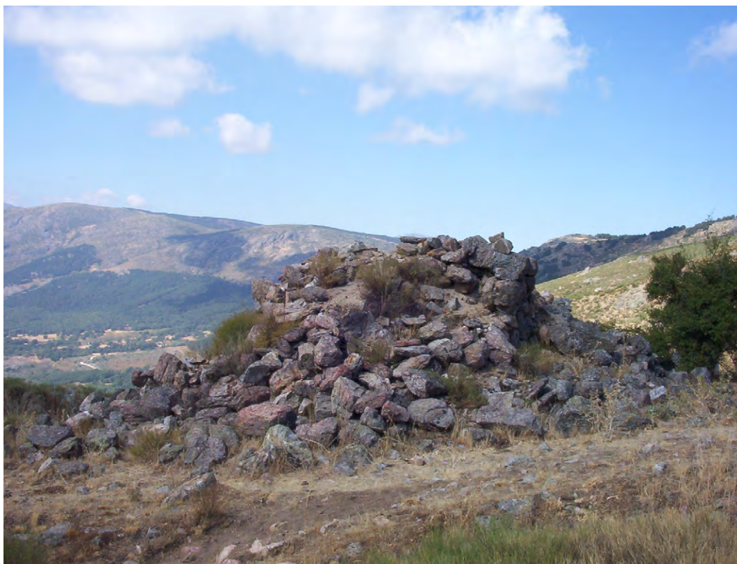
Figura 80: Restos de la chimenea de la fundición de arsénico de Bustarviejo, de finales del siglo XIX.
