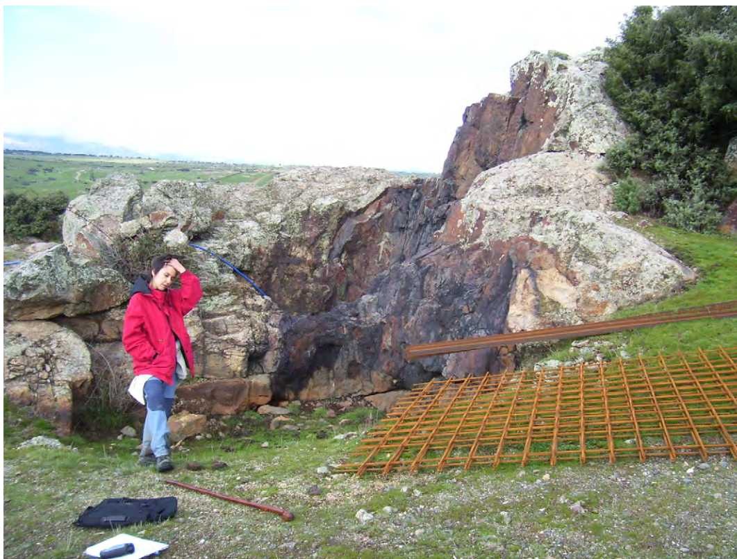
Figura 72: Labores de seguridad en el pocito de Los Lobos, en 2007.
