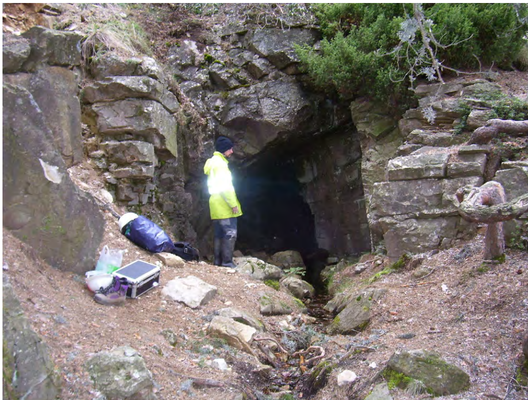
Figura 169: Detalle del emboquille de la mina visita de marzo de 2007. Nótese las juntas perimetrales.
