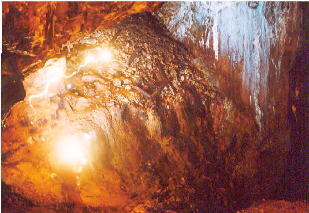
Figura 200: Gran sala o "Plaza de Toros". Pozo Maestro de la mina de Plata de Bustarviejo. A cavidad no tiene sostenimiento artificial alguno.
