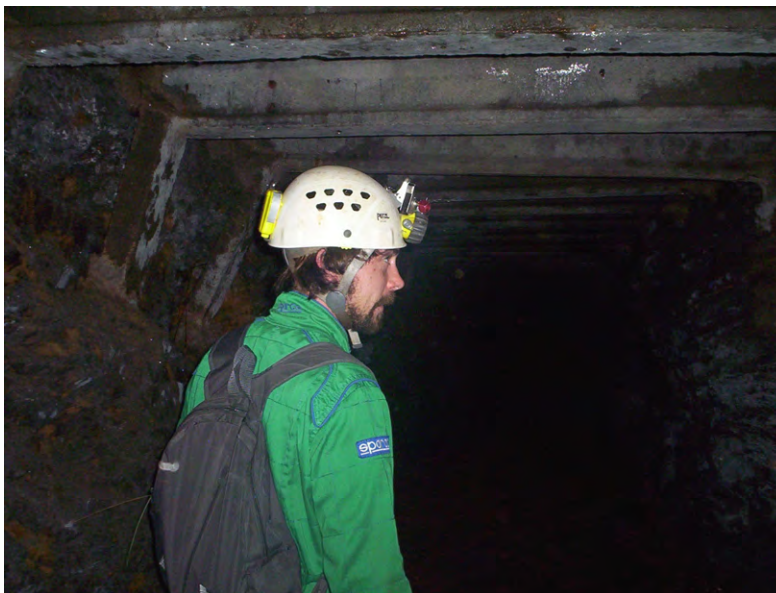
Figura 56: Entibación de una galería de arrastre mediante perfiles metálicos IPN, en un montaje rígido. Pozo Federico, minas de los Guindos, la Carolina (2007). Exploración de galerías abandonadas de hace por lo menos 30 años.
