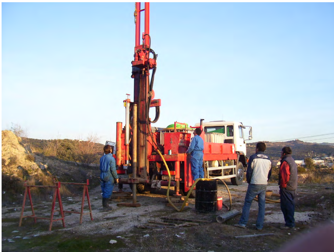
Figura 128: Ejecución de un sondeo en la mina Maribel. Galapagar (2006).
