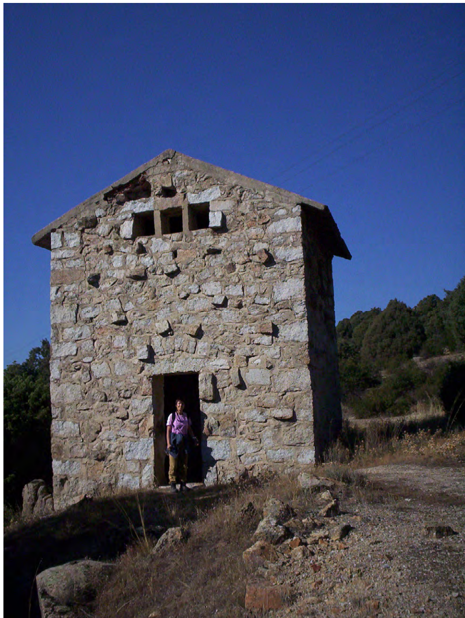
Figura 108: Transformador de la mina de W, Cu de Cantos Negros en Torrelodones (2007).
