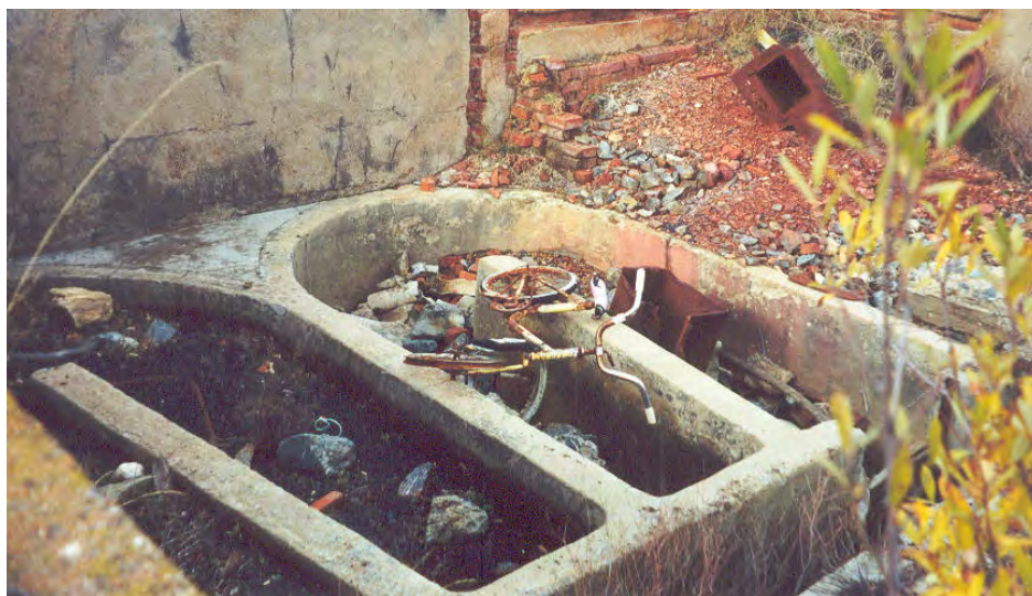
Figura 145: Restos de las celdas de flotación de la mina Fernandito, de Garganta de los Montes (cortesía de Octavio Puche).
