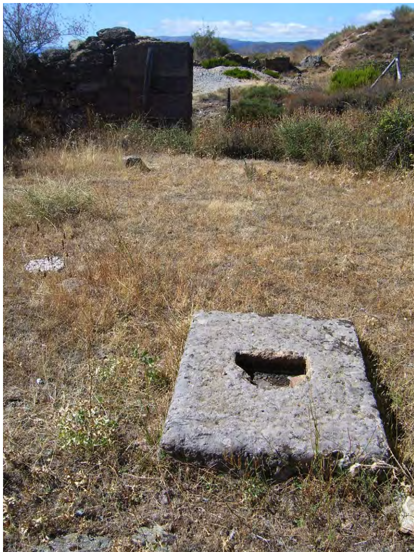
Figura 87: Pie del malacate de Horcajuelo (fotografía de 2007). Se sitúa en las ruinas de una gran edificación junto al Pozo Maestro, colapsado.
